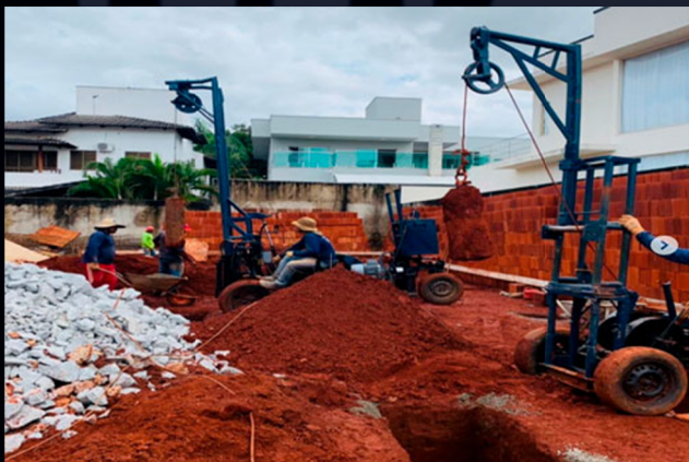
ESTACA COMPACTADA
